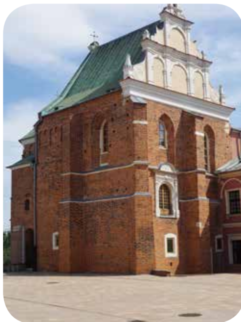
Kaplica Trójcy Świętej, Lublin
